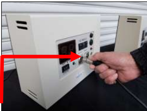
＜子機 通信ケーブルの接続＞
